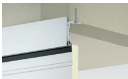
Монтаж перед проемом
