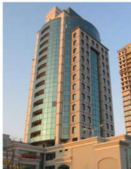
В основе конструктива системы ALT IGF65 лежат несущие комбинированные профили стоек (Рис.2.) и ригелей (Рис.3.), которые соединяются между собой при помощи сухарных элементов.
